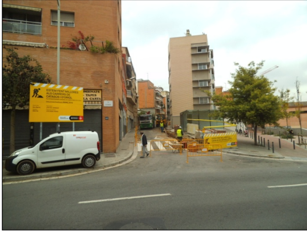
FOTO 1. Vista del carrer d'Oriol des del sud
