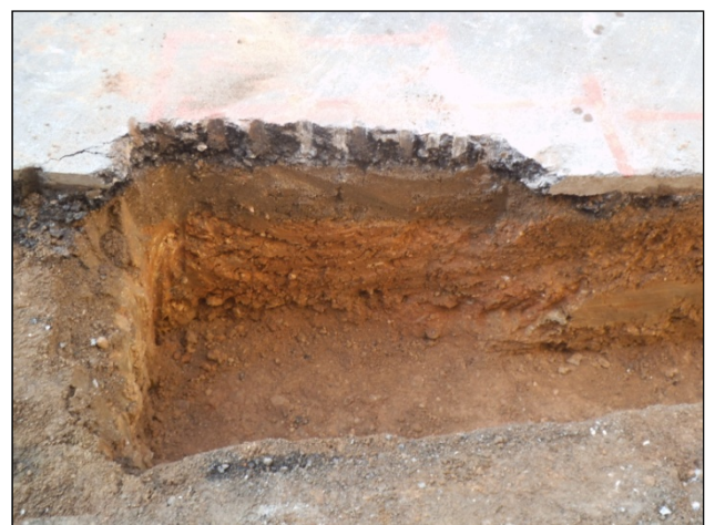
FOTO 16. Vista de detall d'una de les arquetes de la RASA 7
