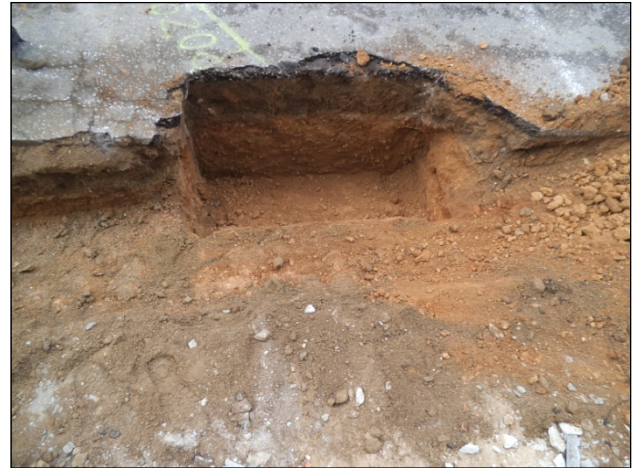
FOTO 6. Vista de detall d'una de les arquetes de la RASA 1
